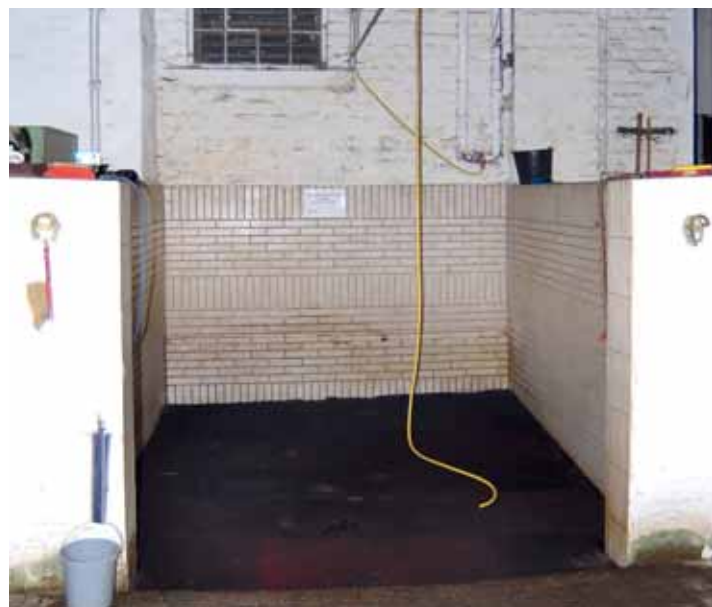
Wasserdurchlässige Softplatten aus Gummigranulat bewähren sich in der Waschbox.
