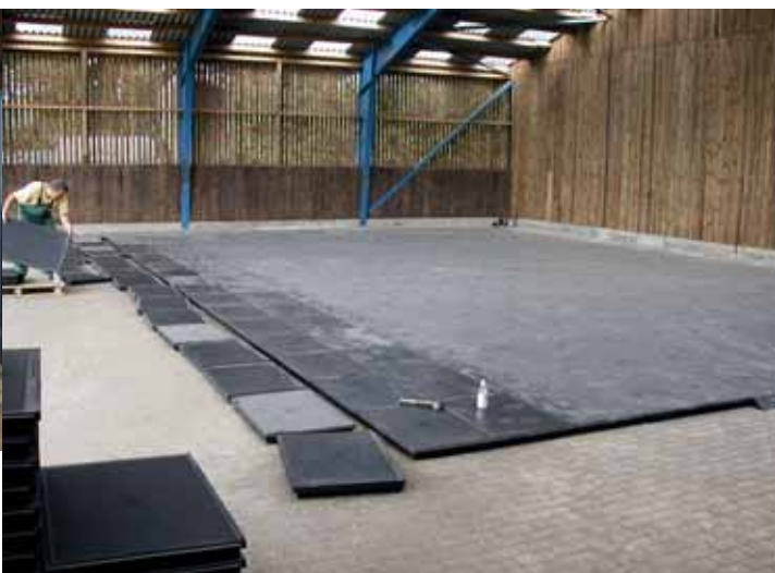
Weichbetten können auch auf einer grösseren Fläche verlegt werden.
