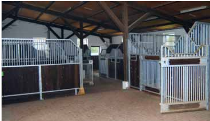
Sicherheit durch Rutschfestigkeit: Gummi-Verbundpflaster sorgen in der Stallgasse für guten Halt.
