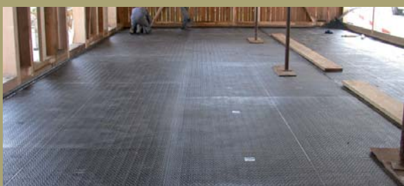
Beliebig grosse Flächen Urin- und Wasserdicht verlegt
