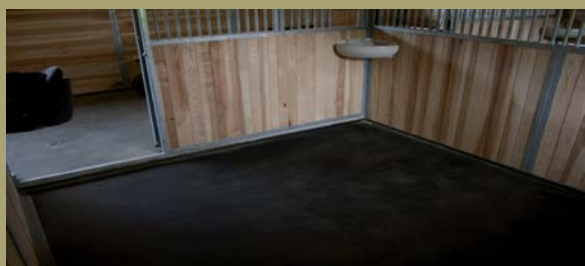
Gummimatte Thermo Grande in der Box verlegt
